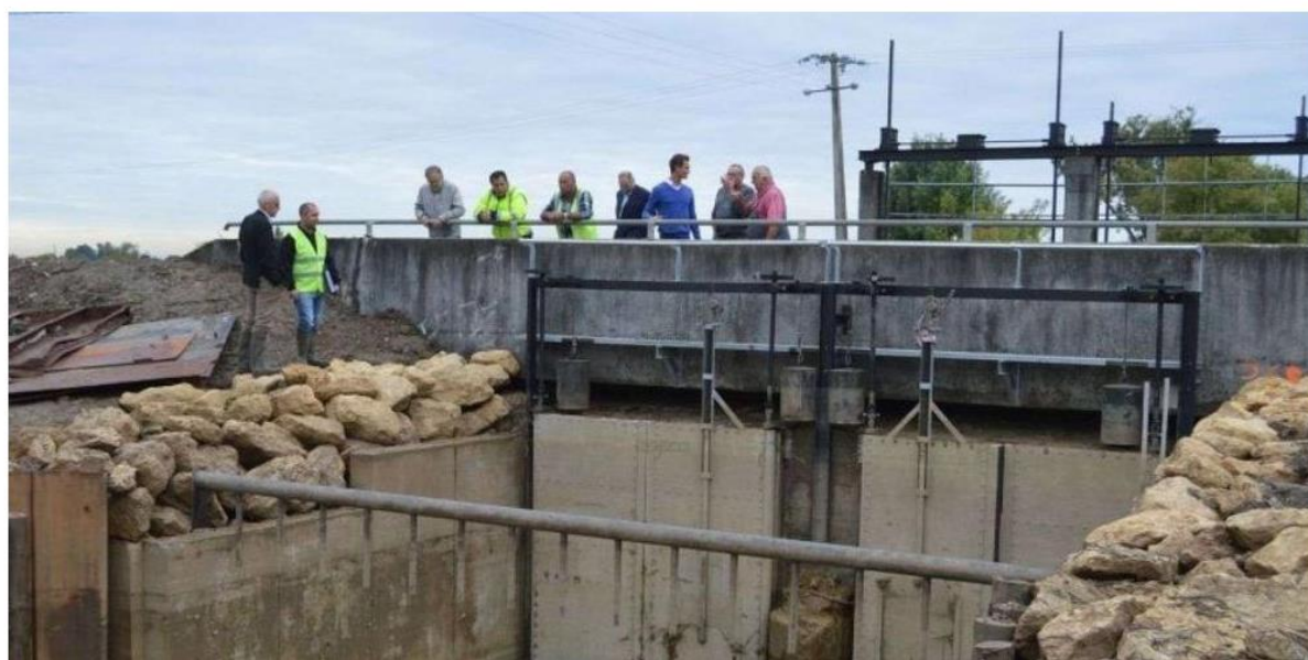
Le pont des Despartins a connu de gros travaux pour éviter les inondations. © Crédit photo : Photo Marine Jay
